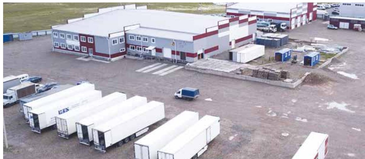
Производственные помещения холдинга Goldman Group
