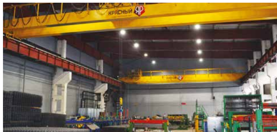
Производственное помещение промышленного парка «Красный Яр»
